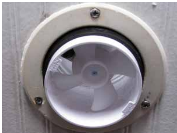
Figur 4: Ventilatorn sedd underifrån. Man kan se den svarta avstängningsknappen upp till höger bakom propellern.
